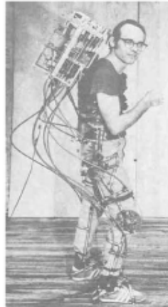
Wisconsin Exoskeleton Orthosis (Seireg & Grundmann, 1981)
